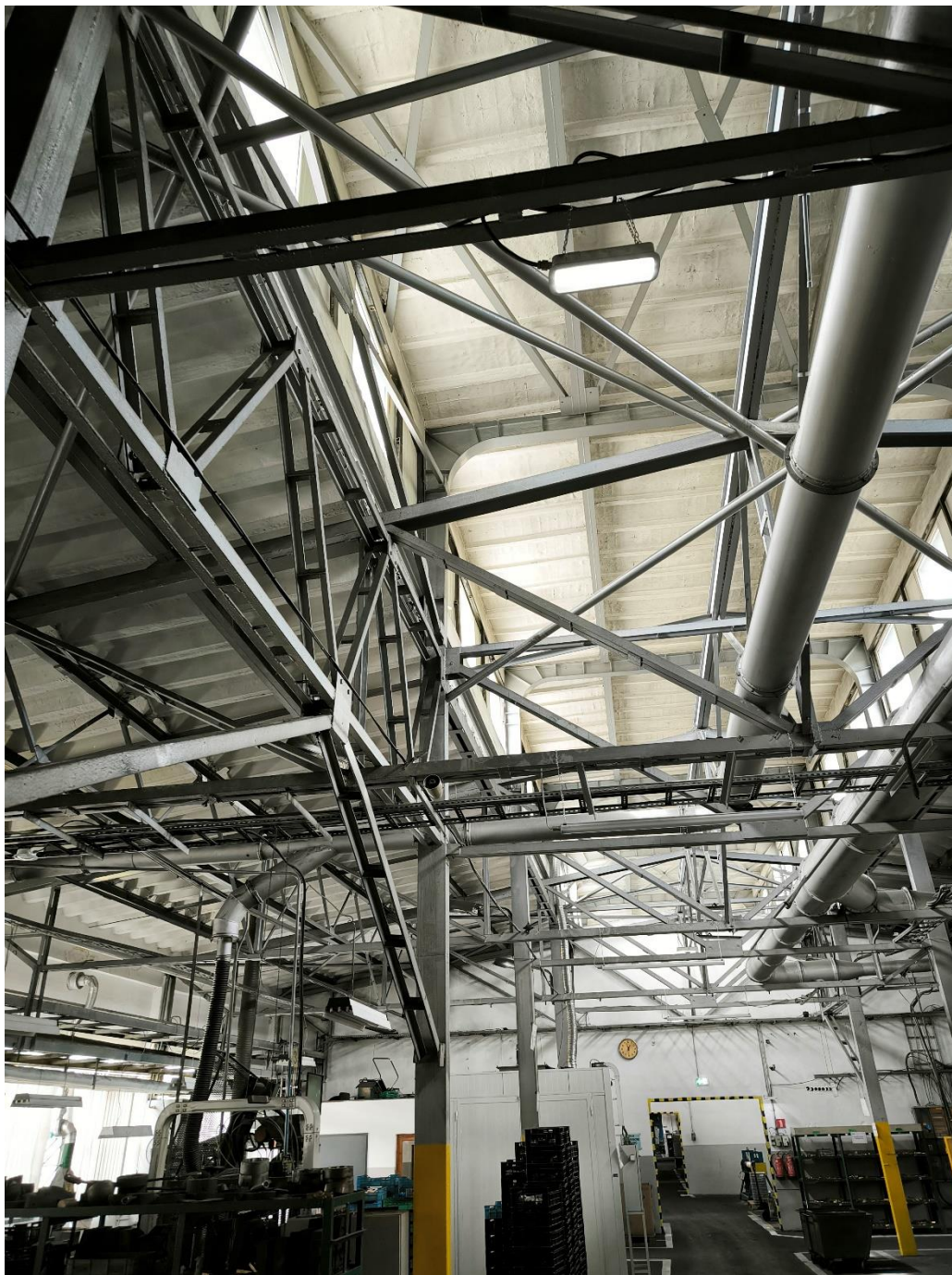
Rysunek 3 Ustrój nośny analizowanego świetlika dachowego – widok ogólny
